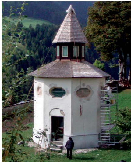
Der Spatzentempel während der Renovierungsarbeiten
