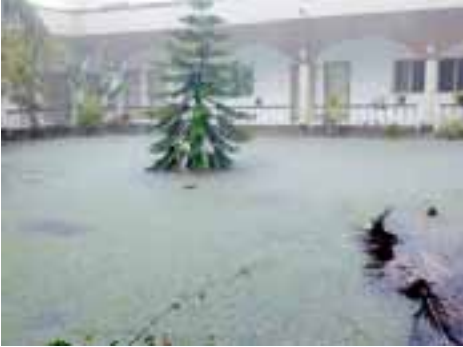
Das Ausbildungskloster in Perumaleri steht unter Wasser.
